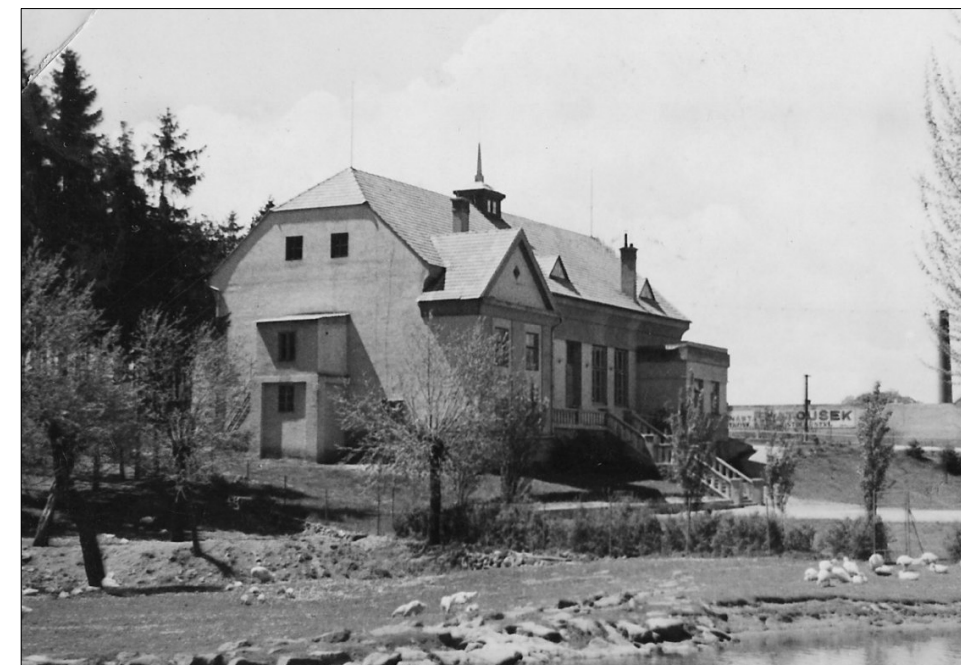
POHLED NA SEVEROVÝCHODNÍ ROH BUDOVY
