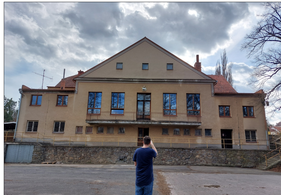
ŠTÍT NA SEVER- POHLED ZE ZPEVNĚNÉ PLOCHY AREÁLU
