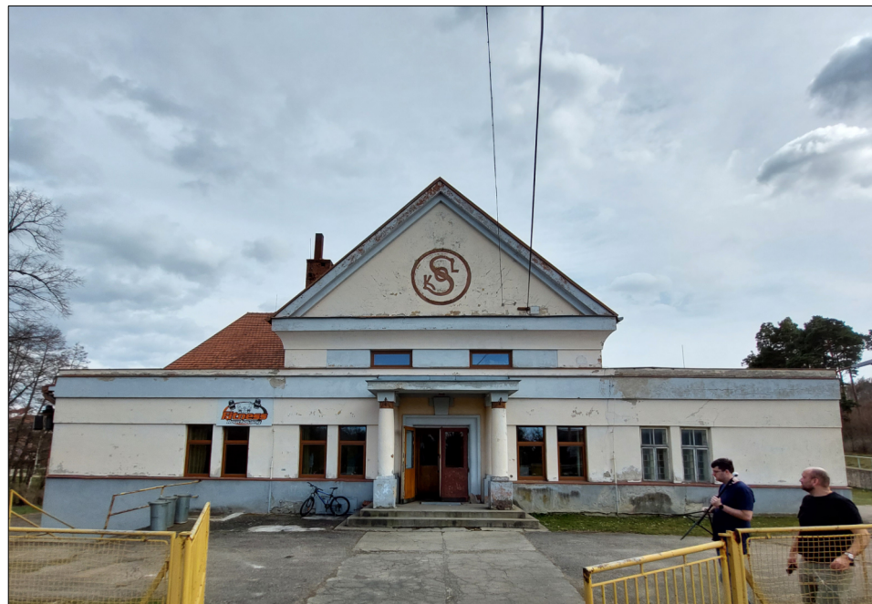
ČELNÍ ŠTÍT - POHLED Z ULICE (ZÁPADNÍ STRANA)
