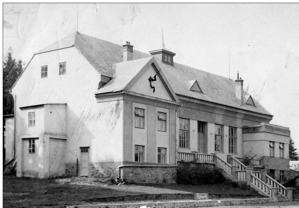
POHLED NA SEVEROVÝCHODNÍ ROH BUDOVY
