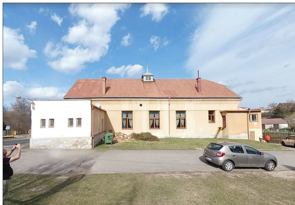
POHLED NA JIŽNÍ ČÁST OBJEKTU
