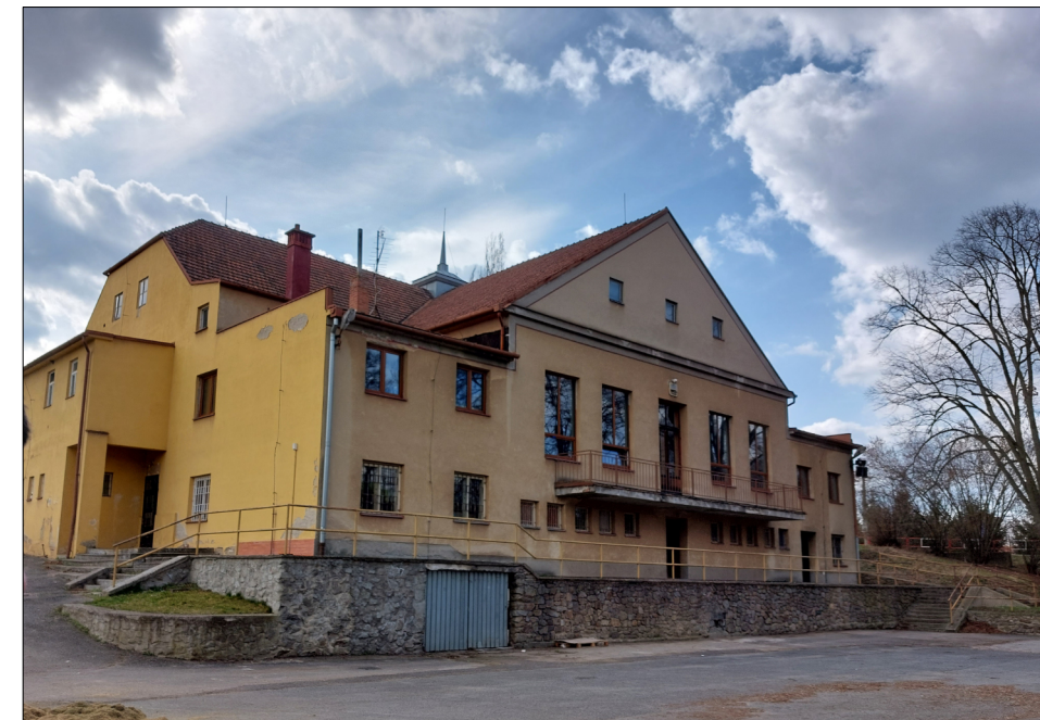
POHLED NA SEVEROVÝCHODNÍ ROH BUDOVY
