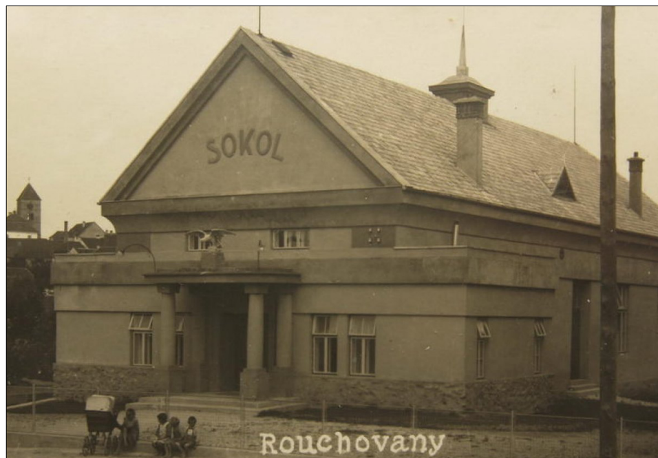
ČELNÍ ŠTÍT - POHLED Z ULICE (ZÁPADNÍ STRANA)
