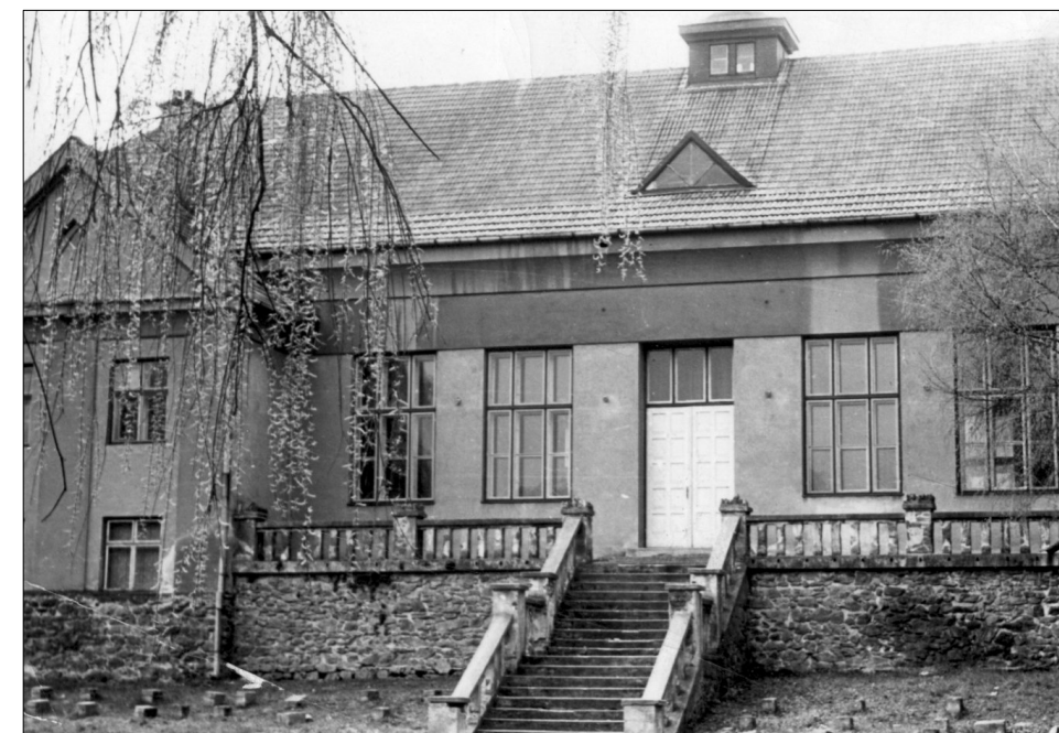
DETAIL SEVERNÍ STRANY OBJEKTU
